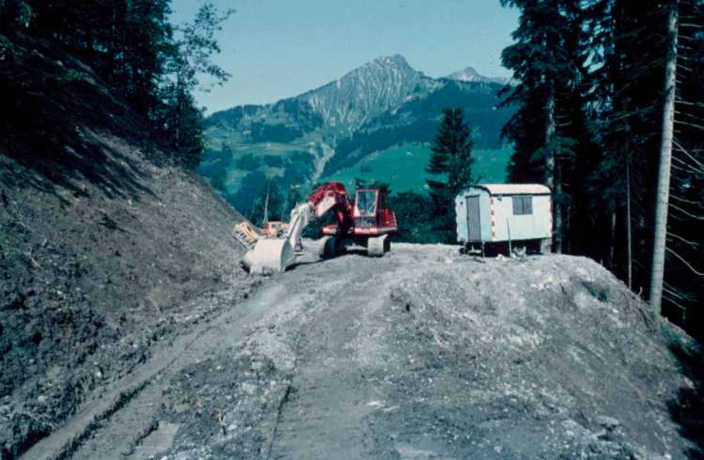
12. Bau von Güterwegen
